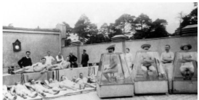
Auf dem Dach des Bades wurden – für Damen und Herren getrennt – Sonnenbäder eingerichtet. Die Verstärkung des Sonnenlichts in den Glaskästen dürfte die Gefahr eines Sonnenbrandes sehr stark erhöht haben.
