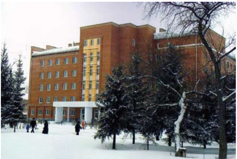
Neubau der Chirurgischen Klinik des Zentralen Stadtkrankenhauses von Iskitim (Oblast Nowosibirsk)
