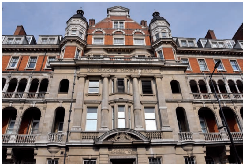
Das alte Hauptgebäude des St. Mary's Hospital
