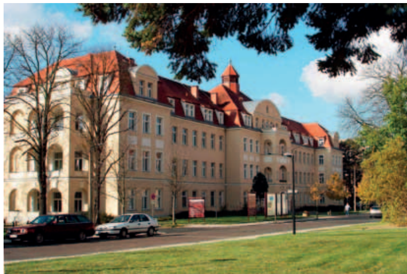
Abbildung 9: Rekonstruiertes und renoviertes „altes“ Bettenhaus 1
