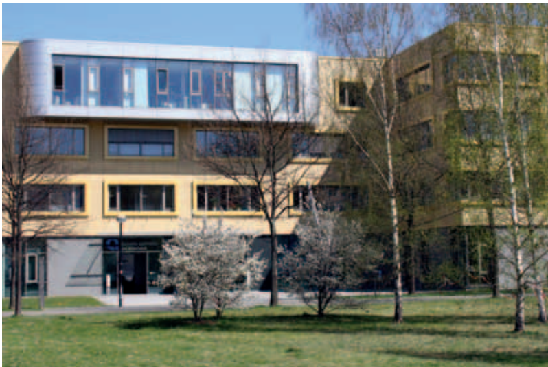
Neues Gebäude der Sächsischen Ärzteversorgung
