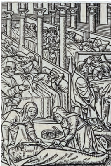
Abb. 2: Mittelalterliches Hospital (um 1500) © Archiv Autor
