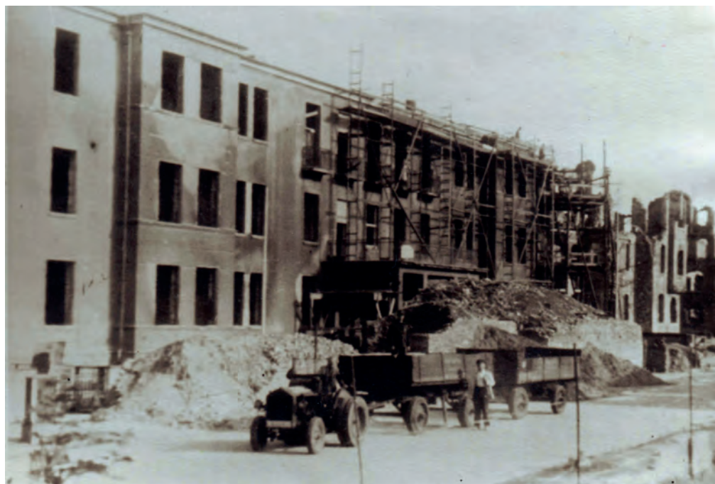
Abb. 6: Beginn des Wiederaufbaus des St. Joseph-Stifts, 1946
