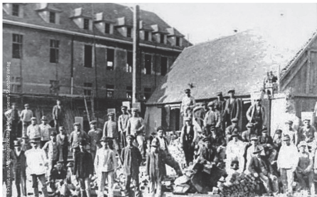
Abb. 1: Bau des St. Carolus-Krankenhauses, 1926
