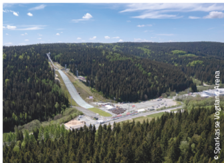
Sparkasse Vogtland Arena in Klingenthal
