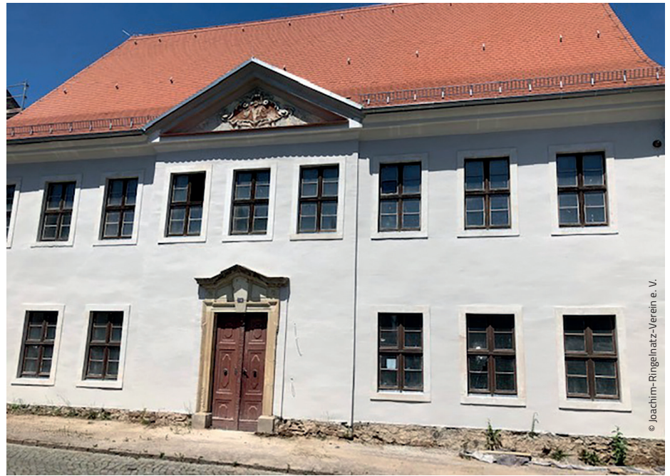
Das Geburtshaus von Joachim Ringelnatz in Wurzen während der aktuell noch laufenden Sanierung. Die Neueröffnung ist im Frühjahr 2023 geplant.
