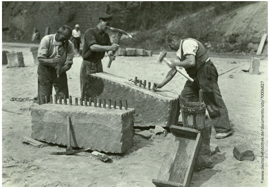
Steinbruch Mühlleithe bei Lohmen, Elbsandsteingebirge. Ausschläger bei der Arbeit. Werksaufnahme, 1954
